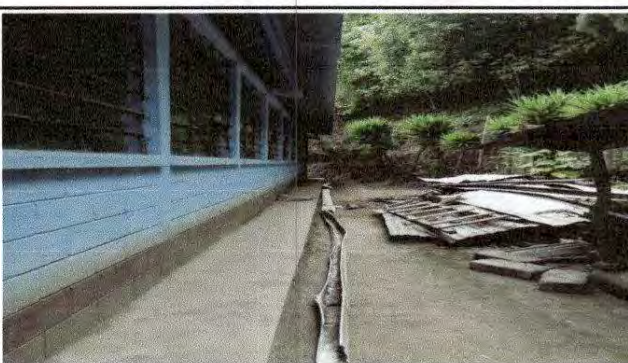
Foto 4: 7.2 Sustitución de canales de pvc.
