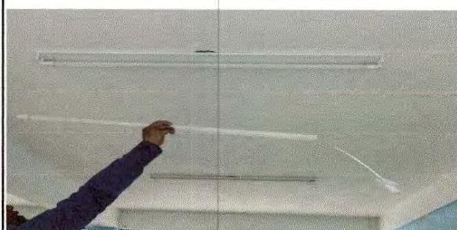
Foto 12: 17.1 Reparación de lamparas
