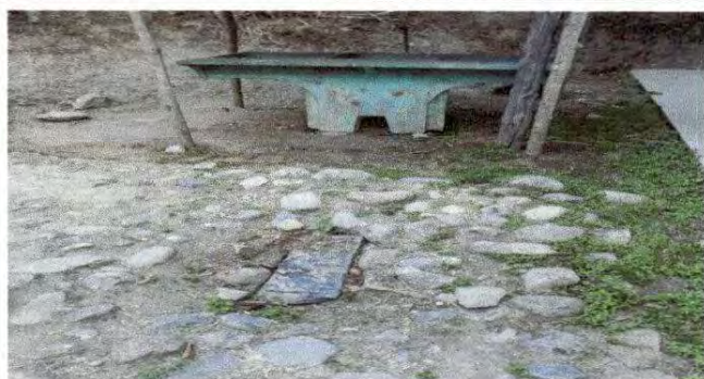
Foto 9: 14.7 Sustitución de reposadera.
