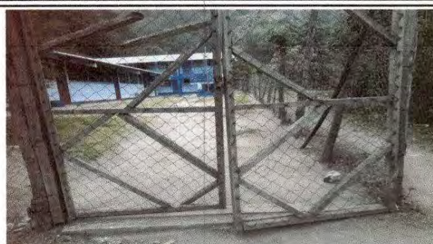
Foto 2: 4.5 Sustitución de porton de metal.
