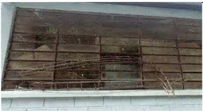
Foto 3: 5.6 Sustitución de balcones de metal.
