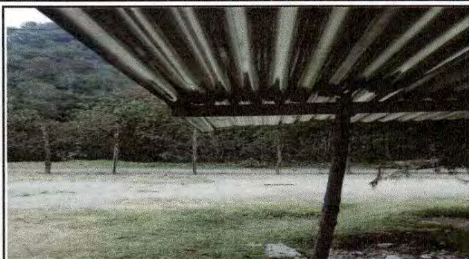
Foto1: 2.2 Sustitución de estructura de madera por metal.
