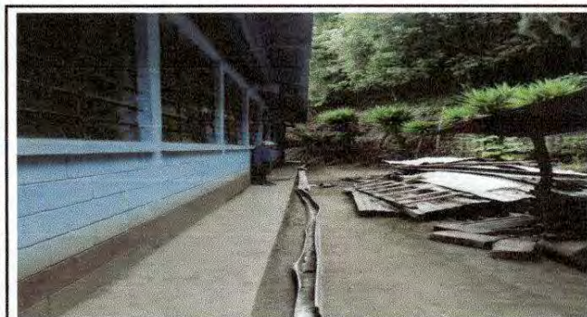
Foto 5: 7.3 Reparación de bajada de agua pluvial, tubo PVC 3"
