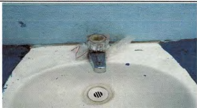
Foto7: 10.9 Sustitución de grifos
