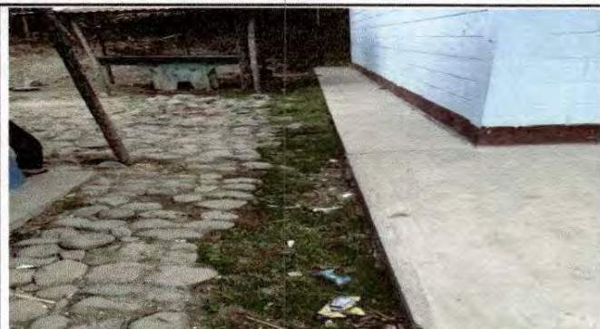
Foto 8: 14.4 Sustitución de tubería PVC línea principal aguas pluviales
